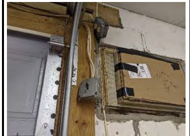
B: Loose conduit and switch boxes
